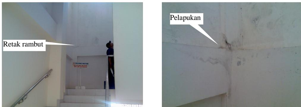
Gambar 1. Retak rambut dan pelapukan pada daerah pertemuan balok-kolom
