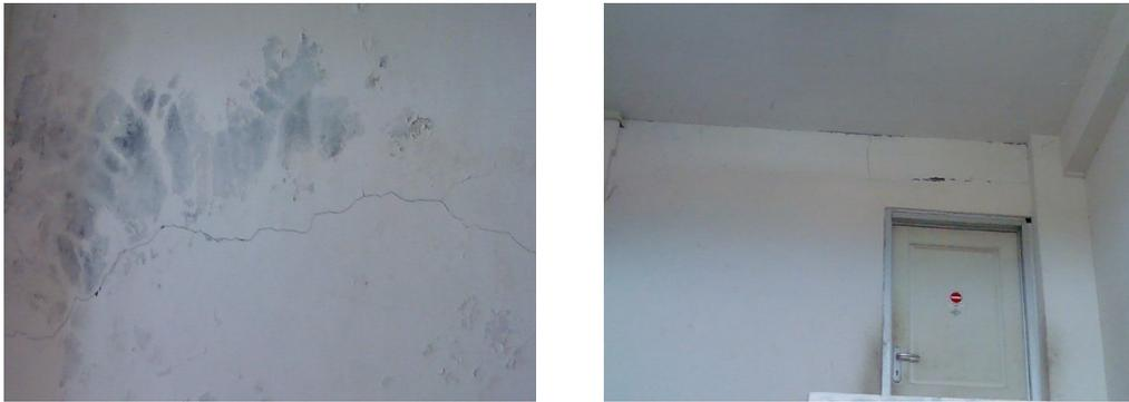
Gambar 2. Retak rambut pada dinding dan plafon
